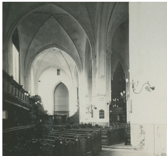
▲ Elektrische verlichting (fotograaf onbekend, Groninger Archieven).
